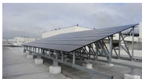
太陽光パネル（新病棟屋上）
