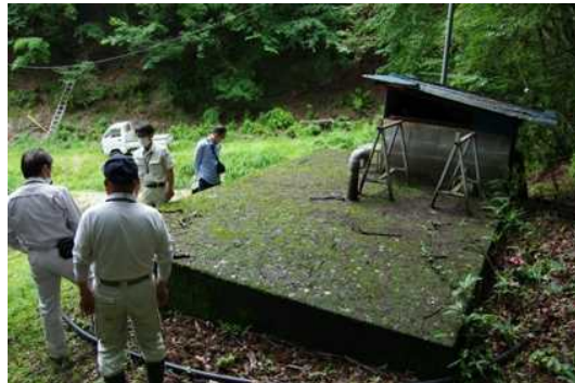
甲州市鍛冶屋沢地区 小規模水道処理設備
