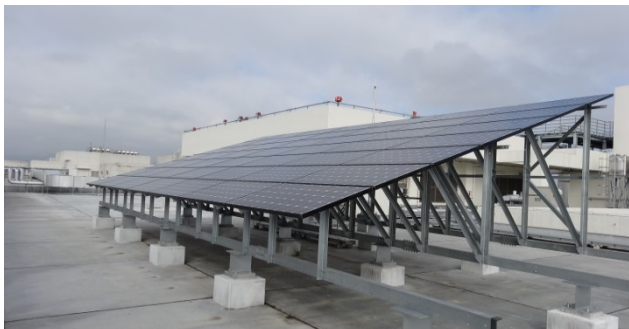
太陽光パネル(新病棟屋上)
