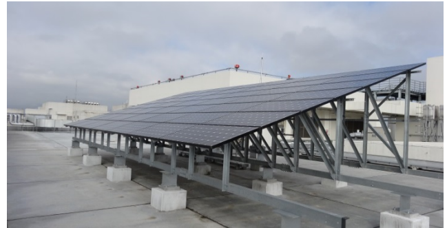
太陽光パネル(新病棟屋上)
