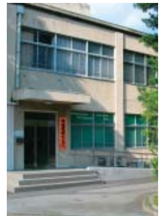
保健管理センター Health Care Center
